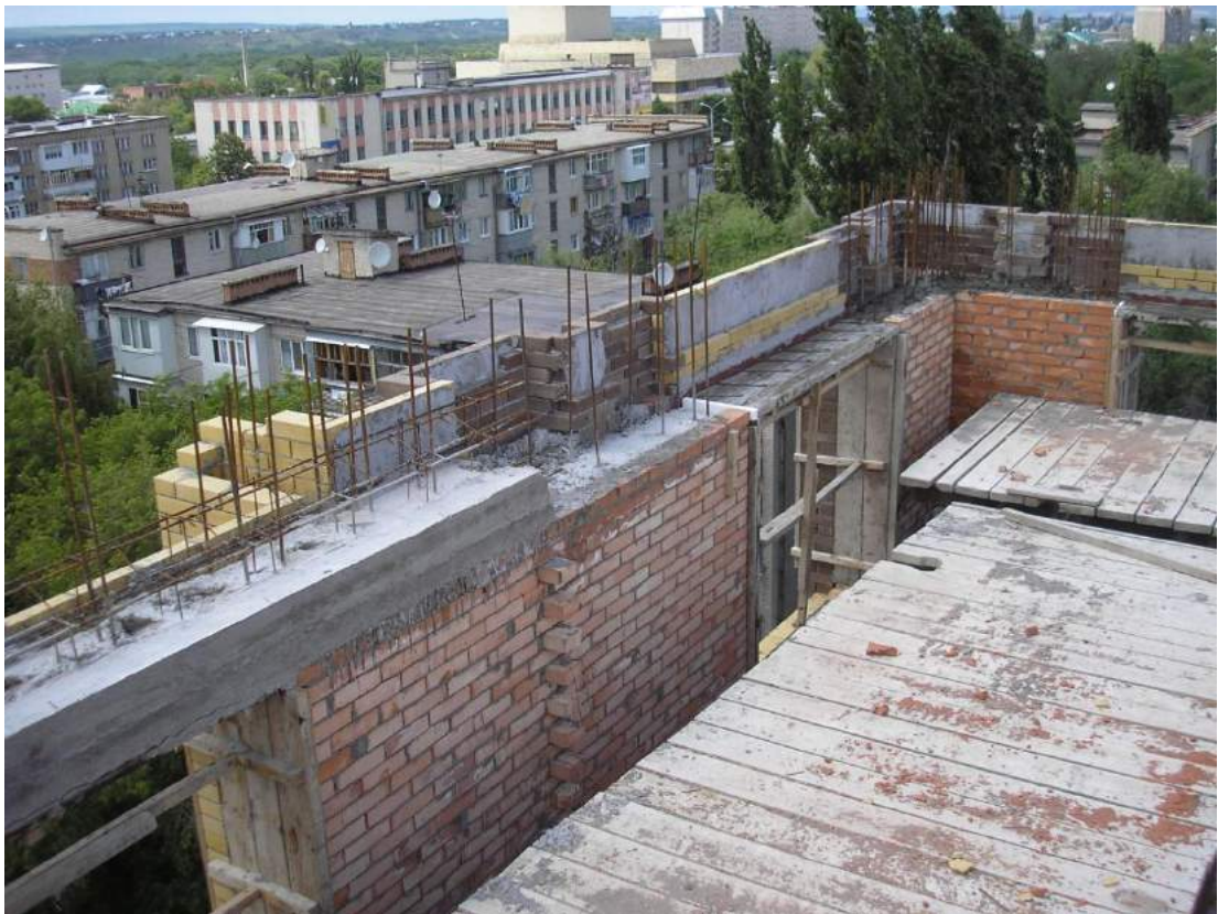
Рисунок 1.10 – Фрагмент многослойной стены 10-ти этажного дома в г. Черкесске. Устройство надпроемных перемычек.
