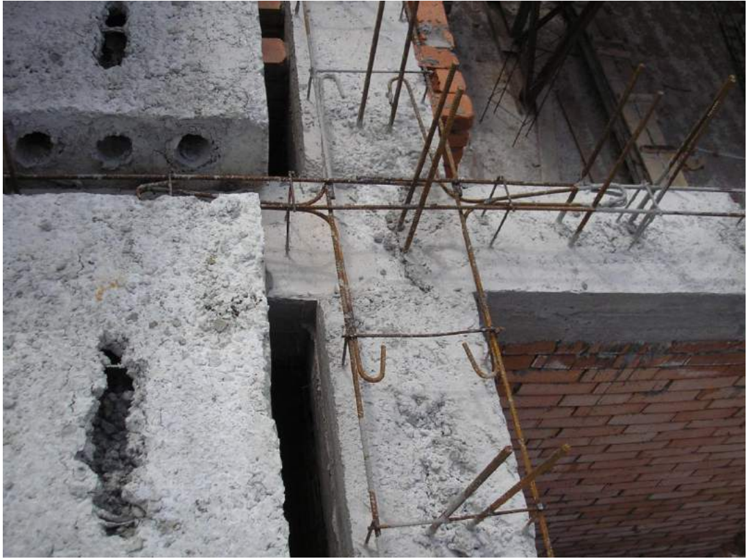
Рисунок 1.9 – Фрагмент многослойной стены 10-ти этажного дома в г. Черкесске. Устройство антисейсмического пояса в уровне перекрытий
