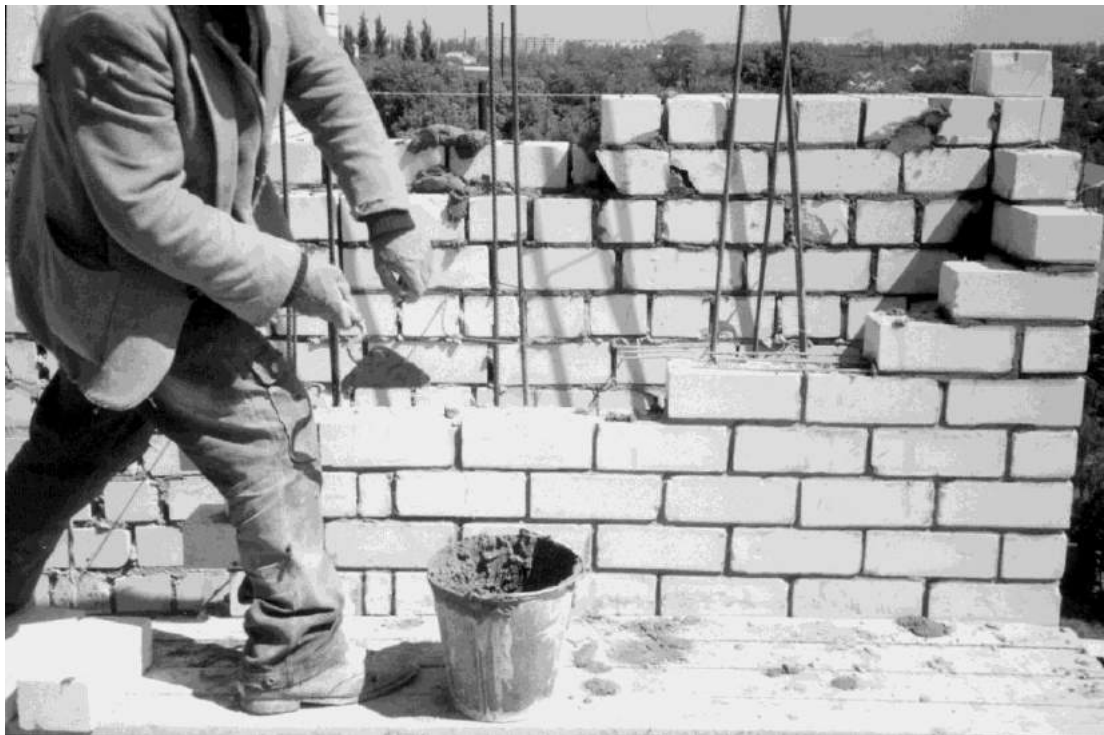
Рисунок 1.5 – Фрагмент многослойной стены 12-ти этажного дома в г. Краснодаре
