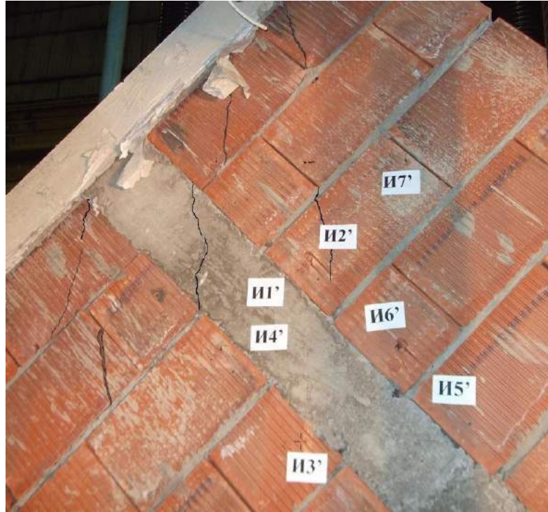
Рисунок 2.40 – Раскрытие трещин в образце ВК-2. №=28 т
