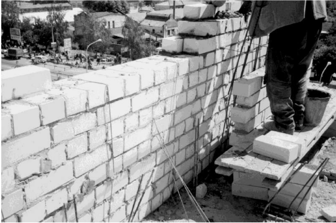
Рисунок 1.2 – Наружная стена 12-этажного жилого здания в г. Краснодаре
