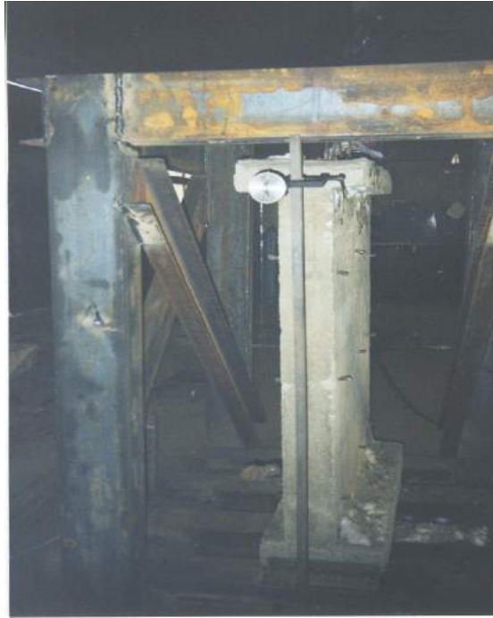
Рисунок 2.5 – Установка прогибомера при испытании однослойного фрагмента
