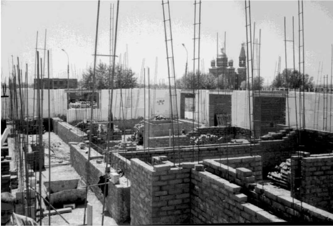
Рисунок 1.4 – Возведение 9- 14-ти этажного дома в г. Краснодаре
