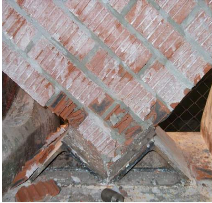
Рисунок 2.23 – Разрушение образца С2-1 – смятие кирпича в опорной части образца
