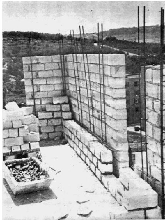
Рисунок 1.1 – Фрагмент трехслойной стены высотного дома в г. Кишиневе
