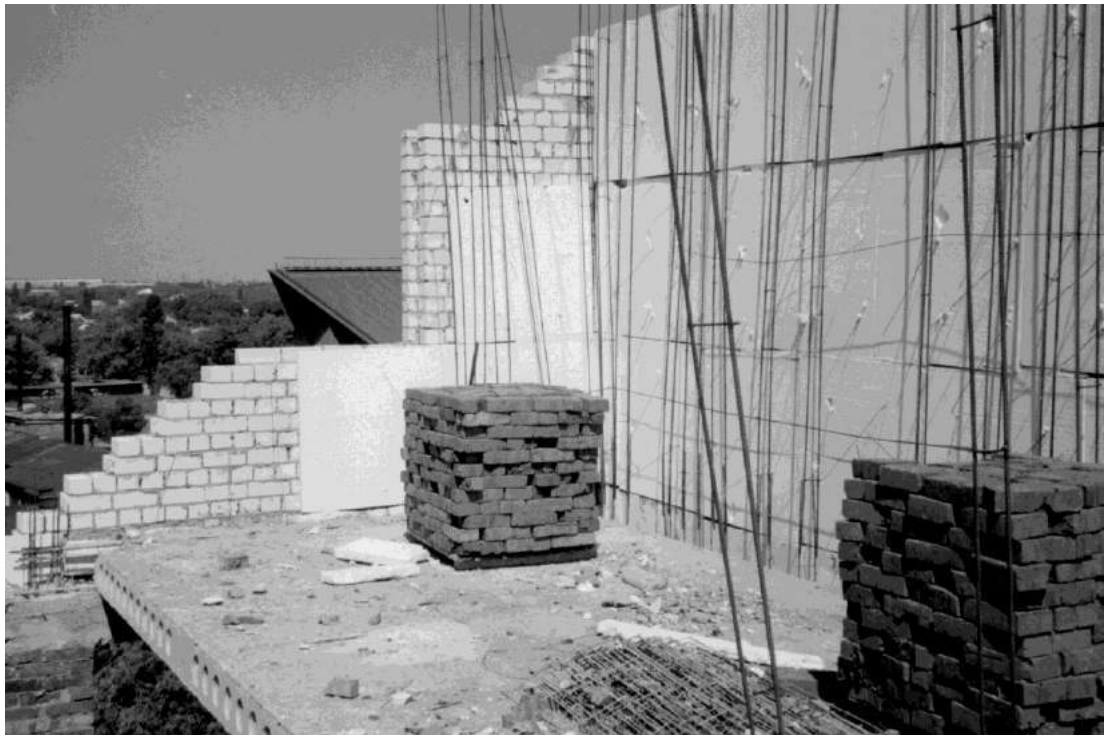
Рисунок 1.3 – Наружная стена 12-этажного жилого здания в г. Краснодаре
