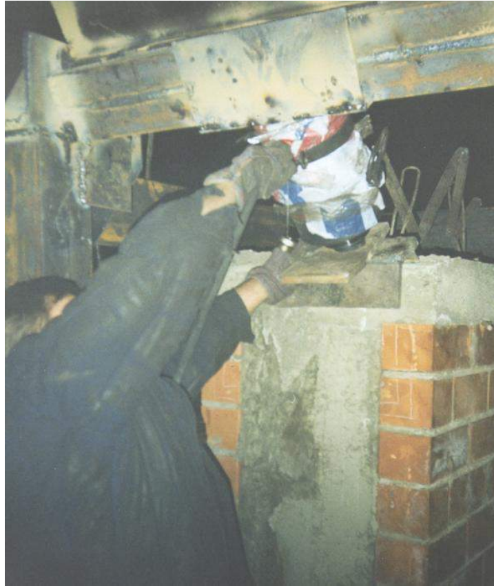
Рисунок 2.1 – Установка домкрата в рабочее положение
